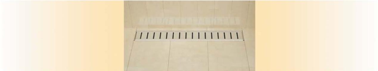
5. Nach dem Trocknen kann mit der Verfließung des Bodens begonnen werden. Der Spalt zwischen der Entwässerungsrinne und der Fliese wird mit flexiblem Silikon in Bodenfarbe gefüllt.
